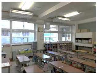
【空調設備・換気設備を備えた教室】 新型コロナウイルス感染症対策として空調・換気設備を整備し、クラスター発生リスクを低減
