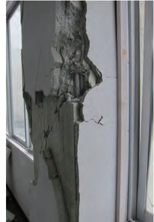
＜鉄筋が露出した柱＞
