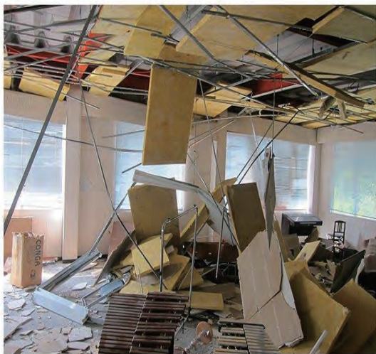
＜天井材の落下＞
