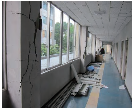
＜校舎内の柱に亀裂＞
