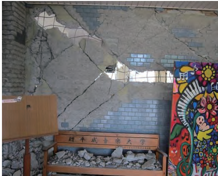
＜崩壊し鉄筋が露出した壁＞
