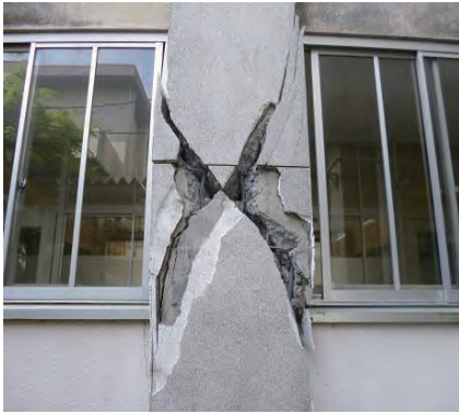
＜崩壊し鉄筋が露出した壁＞
