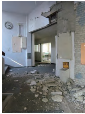
＜校舎内の柱に亀裂＞
