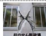
柱のせん断破壊
